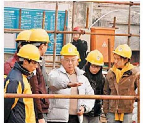
港大師生到幼兒園倒塌現場視察情況。
